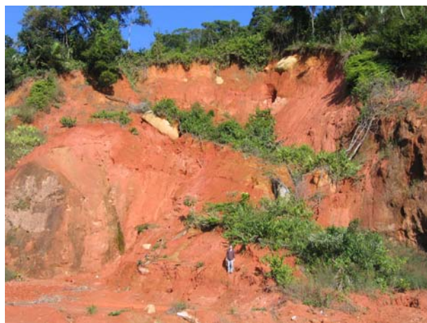
Talude de corte com escorregamento de solos e blocos rochosos.
