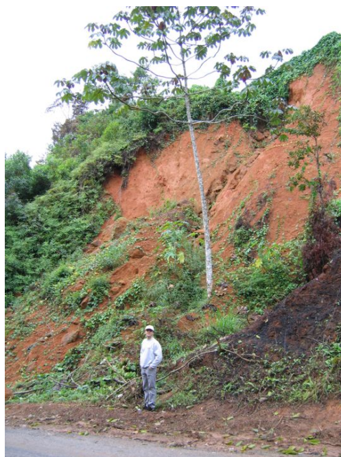
Escorregamentos em talude de corte de via de acesso.
