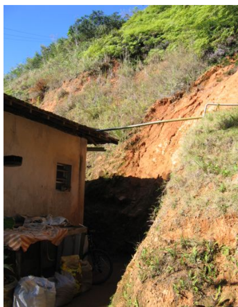
Cicatriz de escorregamento em talude de corte próximo à moradia.
