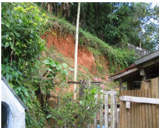
Escorregamento em talude de corte próximo à moradia
