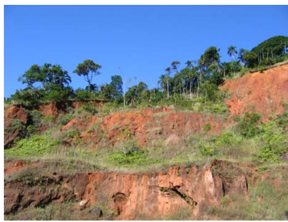
Abatimento de grande porção de solo do topo do talude.
